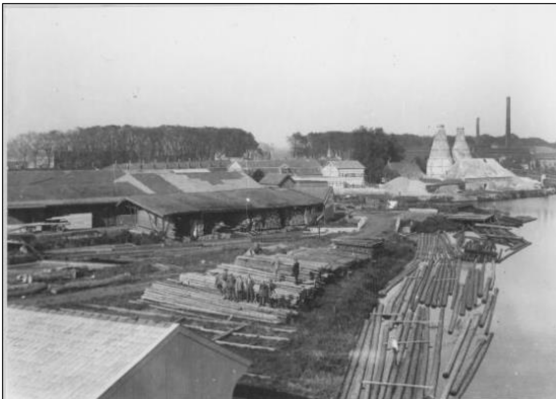
Afbeelding 11. Foto uit 1923 van de kalkfabriek 'de Etna'. De foto is genomen ten zuidoosten van het onderzoeksgebied, kijkend naar het noordwesten. Op de voorgrond is een houtzagerij te zien, die ten zuiden van de kalkfabriek was gevestigd. Hierachter zijn de kalkovens van de kalkfabriek te zien (bron: http://www.focusgroningen.nl/groningen-van-toen-deel-38/ , http://beeldbankgroningen.nl/ ).
